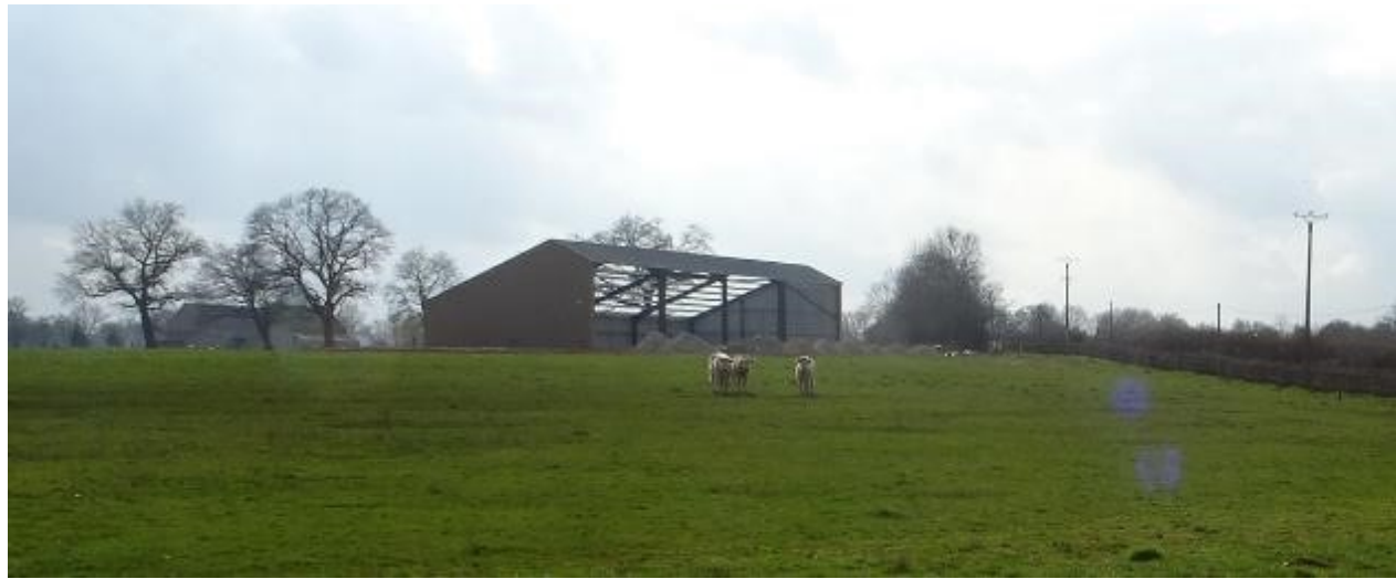
Photographie 9 – Hangar en cours de construction au nord de la ZIP (source : Eco-Stratégie, le 04.03.2021)
