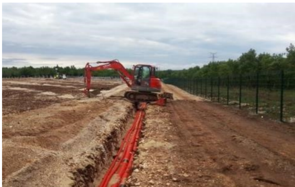
Figure 24 – Exemple de tranchée pour la mise en place des câbles électriques
