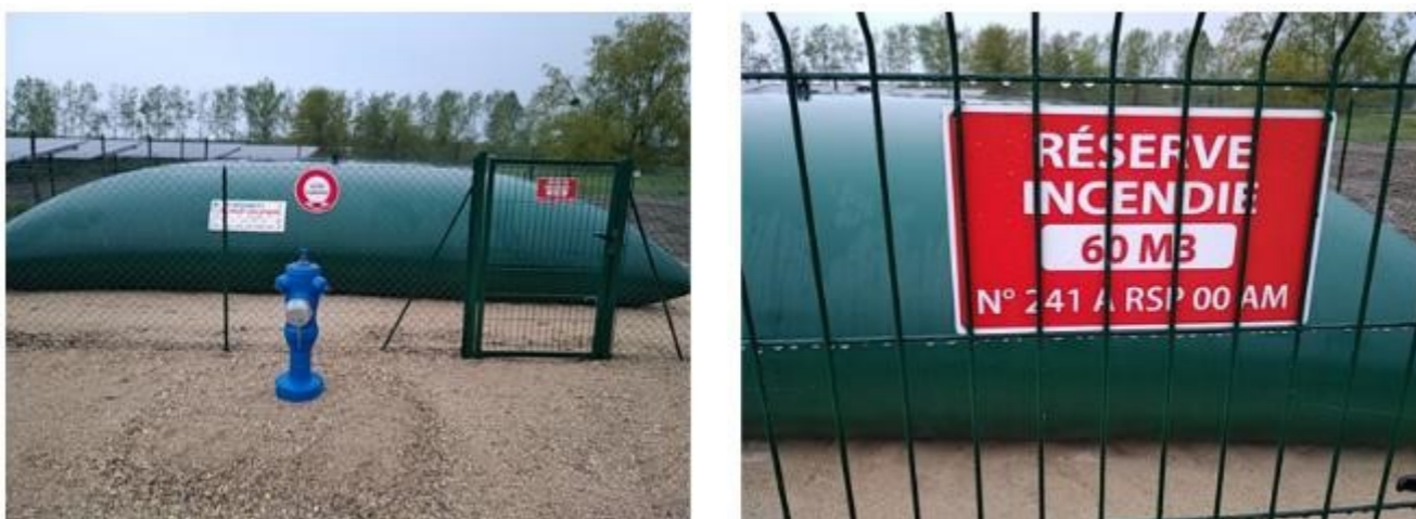
Photographie 4 – Illustration d'une citerne souple de 60 m 3 (source : PHOTOSOL)
