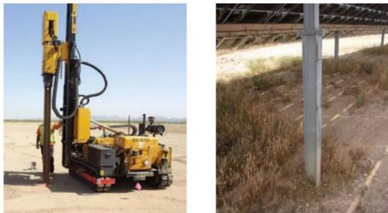
Figure 15 - Technique de fixation des panneaux solaires photovoltaïques
